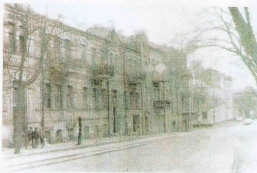
Історична забудова вул. Павлівської кінця XIX століття. Загальний вигляд будинків №№ 17, 19
